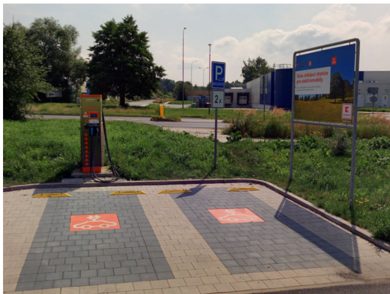
Obrázek 9: Veřejná nabíjecí stanice v Ostrově, u Kauflandu na ul. Jáchymovská
